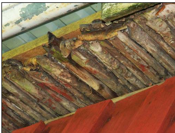
Under det moderna plåttaket finns det gamla taket kvar bestående av slanor och näver. (Foto: Agne Adolfsson)
